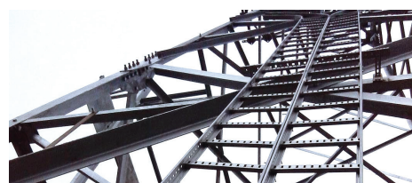
6-метрові лотки драбинного типу
