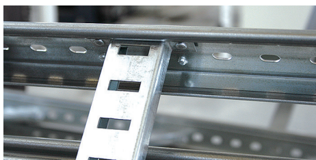
Клінчінг – вібростійке з'єднання
